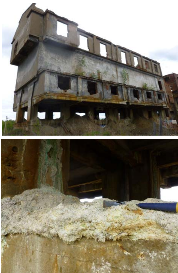
Рис. 1. Здание сортировки руды (рудный склад), сталактиты мелантерита и сульфатные массы в проеме окна. Фото авторов.
