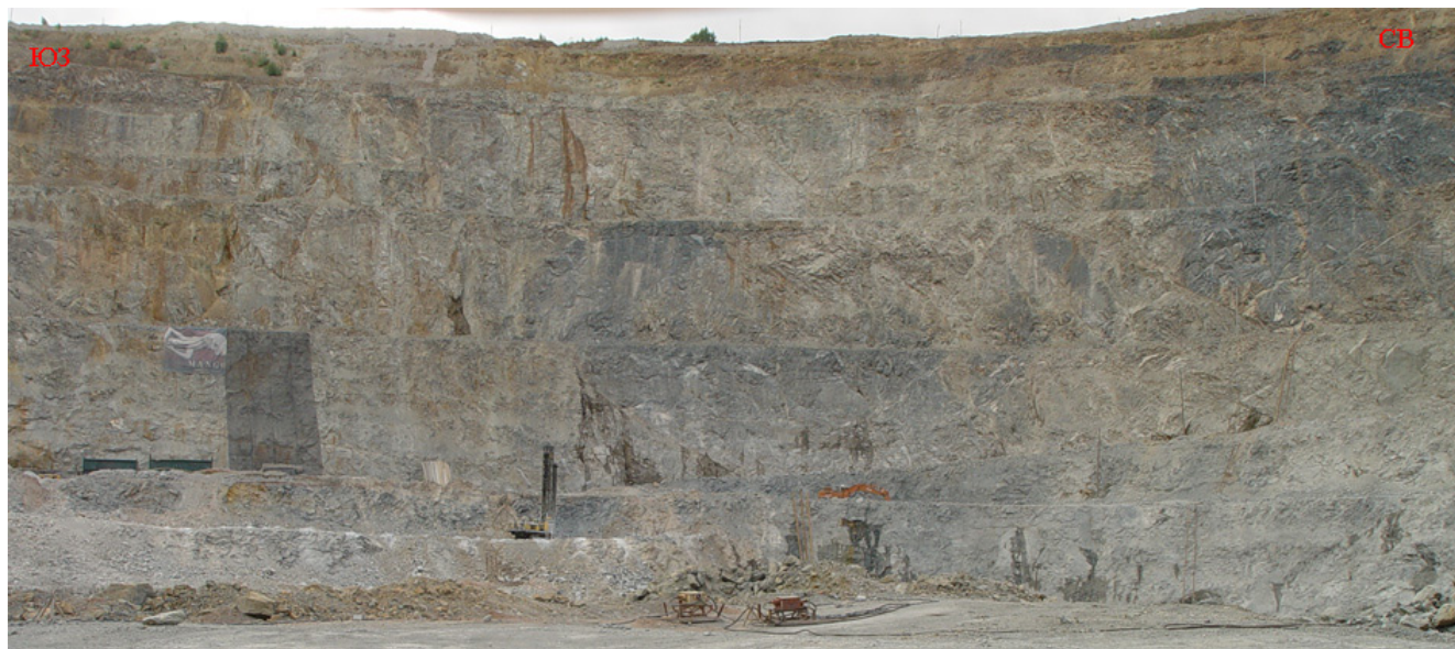
Рис. 4. Система тектонических клиньев в северо-западном борту карьера.
