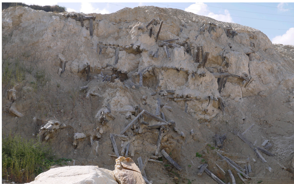
Рис. 1. Остатки крепи подземных горных выработок в борту Светлинского карьера, вскрывшего карстовые отложения.
